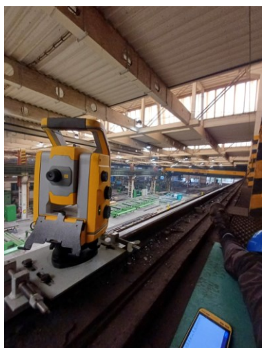
Obr. 4 JD ve výrobní hale DT Výhybkárny a strojírny
